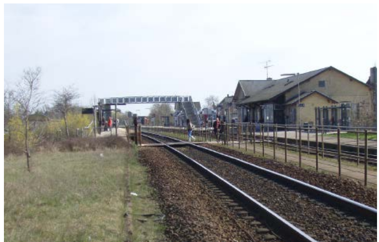
Foto 1 Overgangen over spor 2 med gangbroen i baggrunden
