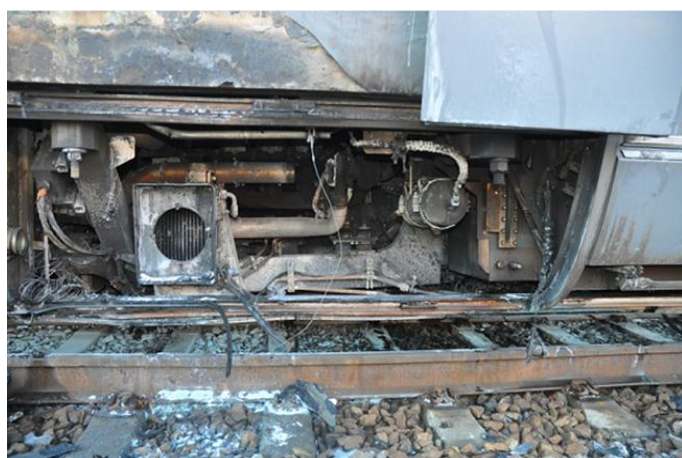
Luftindtag til traktionsanlæg B motor i undervogn MF 5020, vognskørtet er afmonteret.
