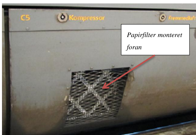
Billede af intakt skørt, metalgitter for luftindtag til gearoliekøler
