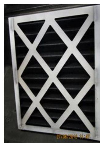
Intakt papirfilter til gearoliekøler
