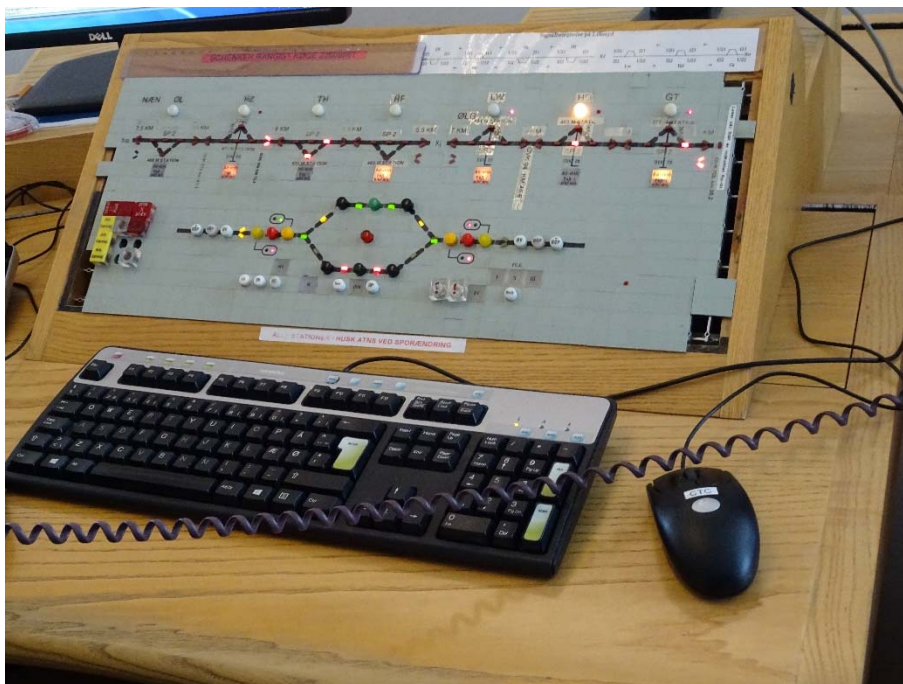
1 Betjeningspanel for "landstationerne" på Lille Syd - tastatur til betjening af Køge station
