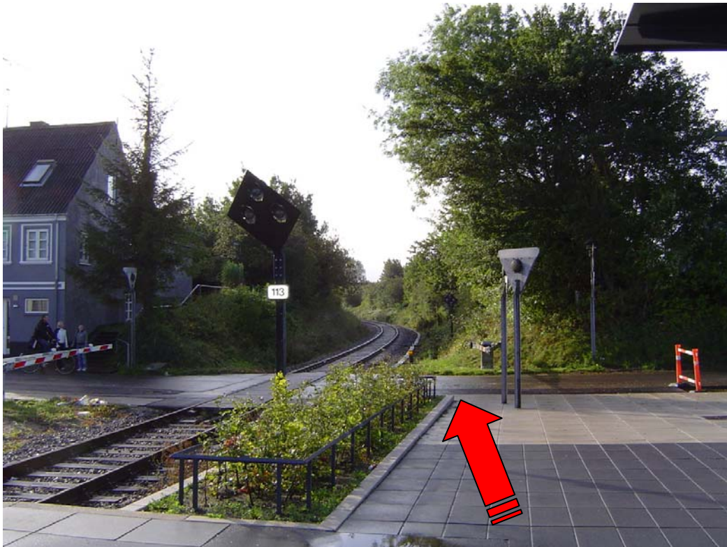
Billede nr. 3 Set fra trinbrættet mod overkørsel 113. Bemærk den uhindrede passage.
