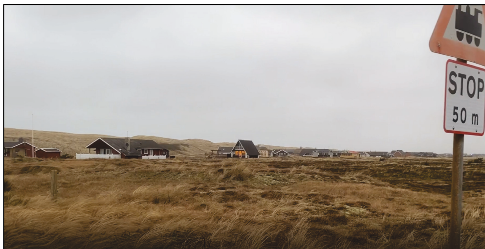
Foto 4: D. 19-01-2022, oversigtsforhold fra Sylphidevej mod nord/vest set ca. 50 meter øst for overkørsel 60 N.
