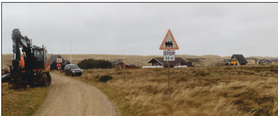
Foto 1: D. 19-01-2022, Sylphidevej set i vestlig retning. Ca. 50 meter før overkørsel 60 N var til højre for grusvejen i en blød venstre kurve opsat færdselstavle A72 jernbaneoverkørsel uden bomme suppleret med UB 11,1 STOP 50 meter. Overkørselens krydsmærke og stoptavle ses lidt længere fremme.
