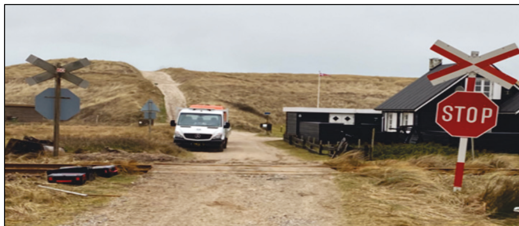
Foto 2: D. 19-01-2022, Sylphidevej set i vestlig retning. Overkørsel 60 N var markeret ved krydsmærke A 74,1 Enkeltsporet jernbaneoverkørsel, der var suppleret med B 13 ”STOP” der stod i en afstand på 2,6 meter fra overkørsel og 1,8 meter fra vej i højre side. Vejens bredde i ovk. var 3,4 meter.
