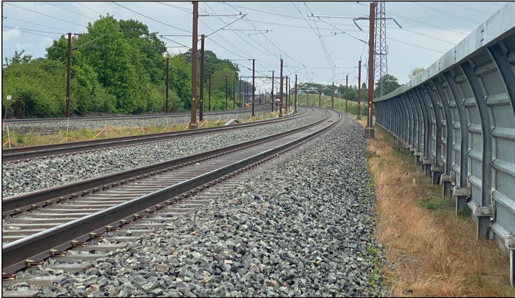
Foto 1: Foto viser oversigtsforhold i østlig retning (togets køreretning) set fra ballastskulderens kant ved 1. hovedspor ud for adgangslågen fra Kværkeby Stationsvej. Påkørsel skete ca. 16 m fremme i sporet.
