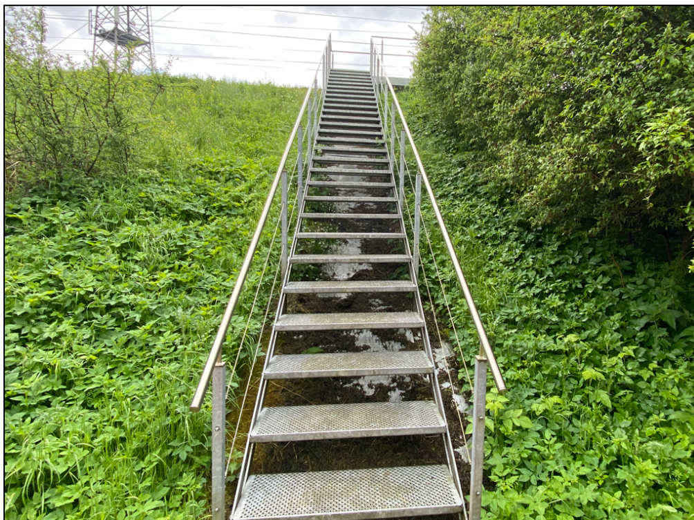
Foto 5: På den nordlige side af jernbanen var der en grusvej, der gik helt op til baneskåningen, hvorfra der var en trappe, som dagligt fungerede som adgangsvej til baneterrænet for Banedanmarks vedligeholdspersonale. Trappen førte direkte op til Kværkeby Station spor 2 (TIB 1).
