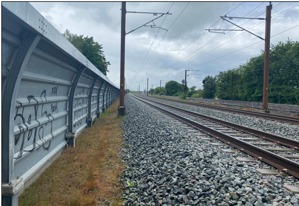
Foto 2: Foto viser oversigtsforhold i vestlig retning (mod togets køreretning) set fra ballastskulderens kant ved 1. hovedspor ud for adgangslågen fra Kværkeby Stationsvej.
