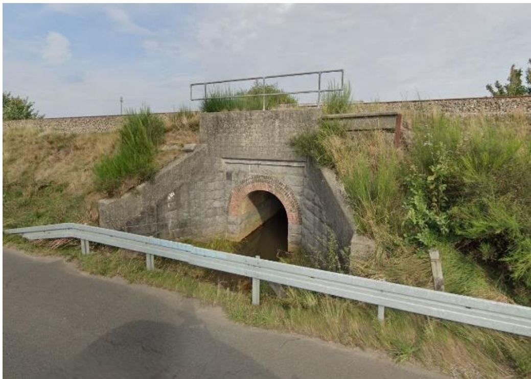
Foto 11. Vandløbsbro i km 87,0. September 2022. Kilde: Google Streetview.
