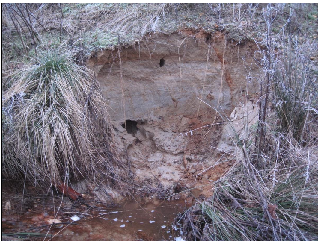
Foto 9. D. 22-01-2015. Brinken på vandløbet nær indløbet til vandløbsbroen. Vand har eroderet grøftesiden. Kilde: Privat foto.
