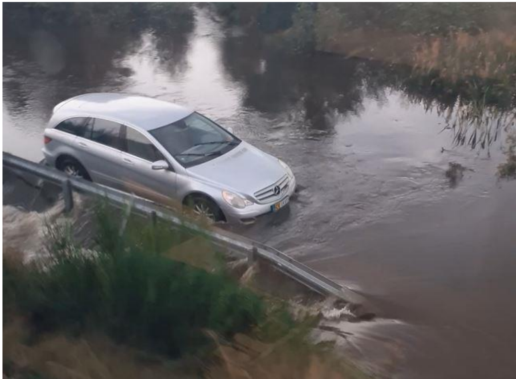
Foto 10. D. 26-08-2022, kl. 18:38. Oversvømmelse ved vandløbsbro i km 87,0. Kilde: Passager i tog 5362.
