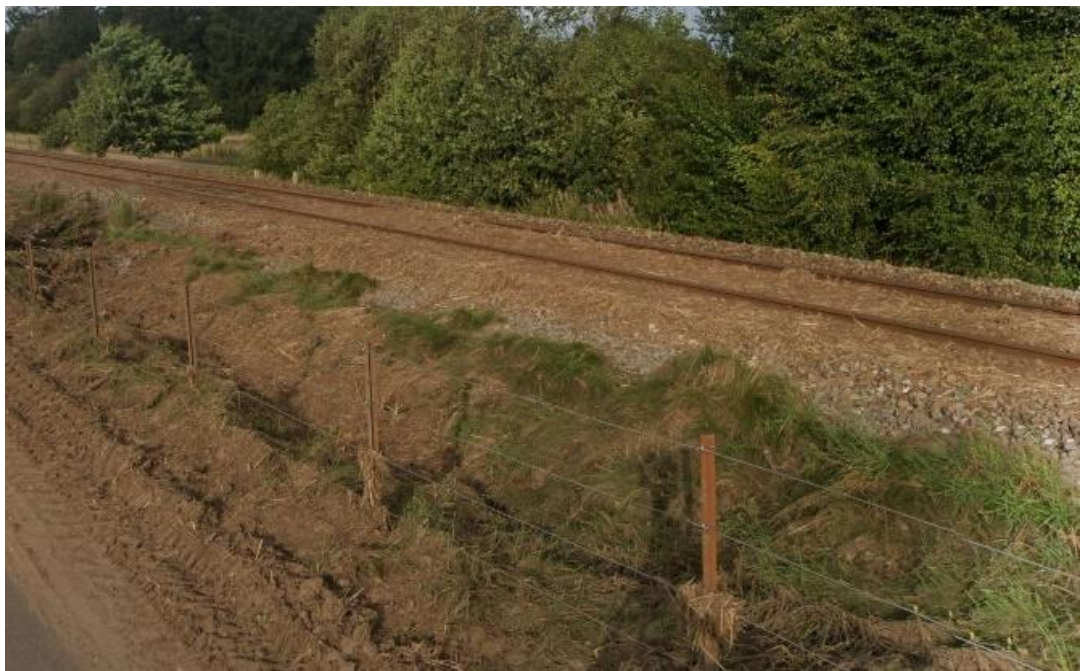
Foto 13. Sporet i km 87,7 set fra Ollingvej. September 2022. Mudder afsat langs heget. Plantedele tilbageholdt af skærverne. Kilde: Google Streetview.
