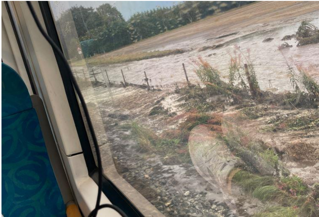
Foto 12. D. 26-08-2022, Oversvømmelse ved vej og spor i km 87,7. Kilde: Passager i tog 5362.
